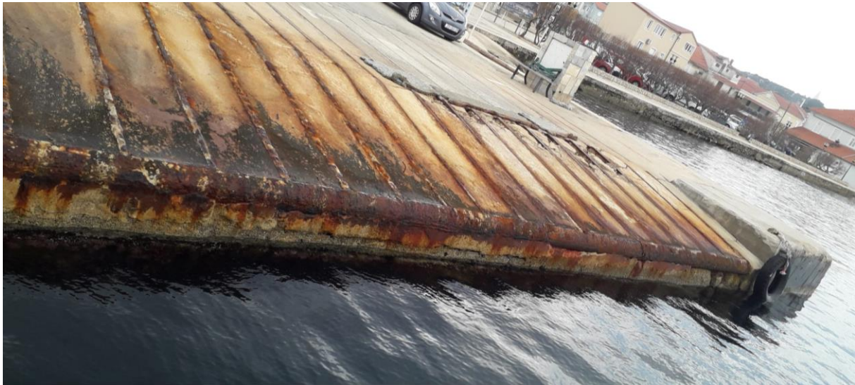
Slika 2.4. Oštećenje betona
