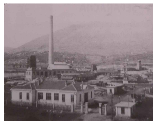
Termoelektrana s rashladnim uređajem
