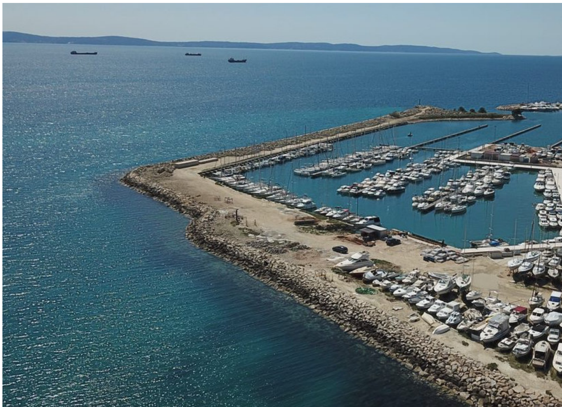
Slika 8.1.1. Trenutno stanje lukobrana Zenta
