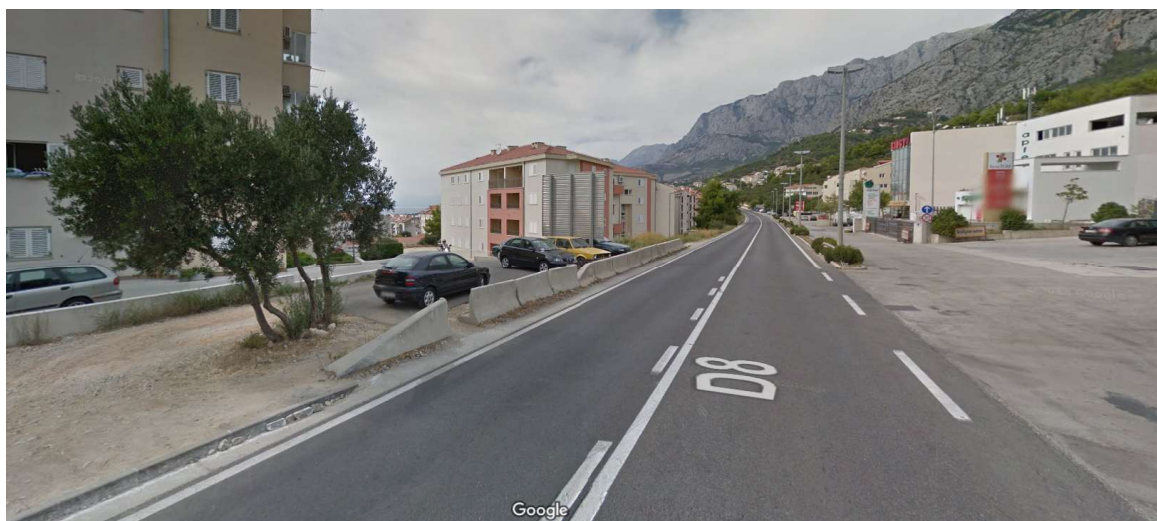
Slika 2.1 Prikaz ceste prije rekonstrukcije [3]
