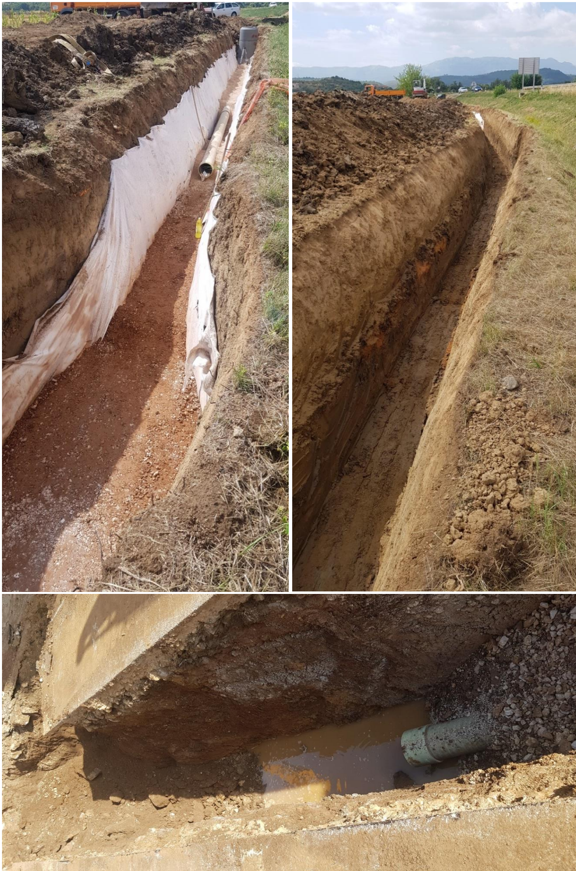
Fotografija 4., 5. i 6. iskop rova i postava geotekstila u mekanom tlu C kategorije
