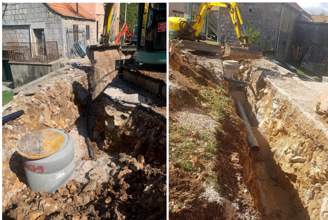
Fotografija 2. i 3. Iskop rova za polaganje cijevi i okana uz kućne prilaze stanovnika
