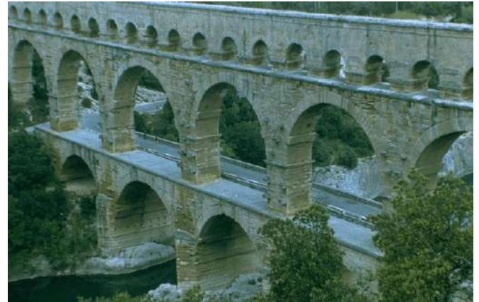
Slika 1.2 – Akvadukt Pont du Gard
