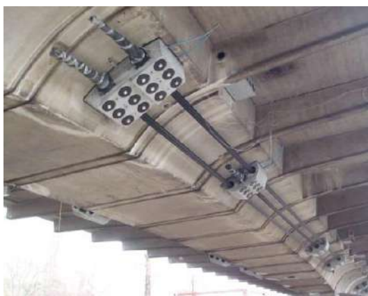
Slika 7.9 –Vanjsko prednapinjanje [20] & [21]
