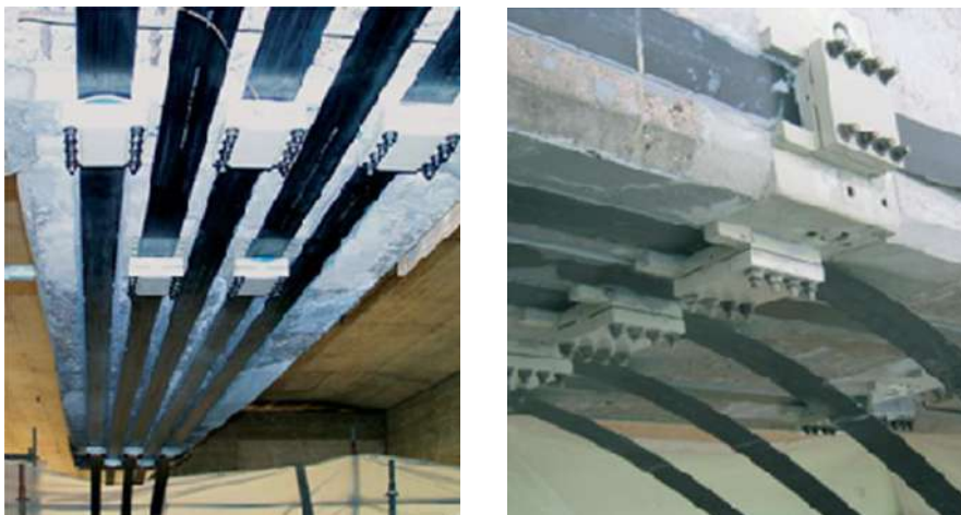
Slika 7.47 – Obnova mosta prednapetim karbonskim trakama
