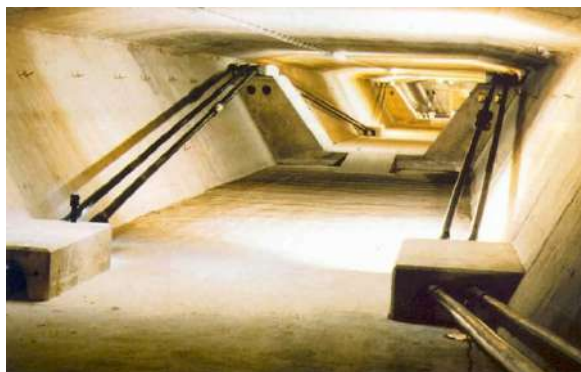
Slika 7.9 –Vanjsko prednapinjanje [20] & [21]
