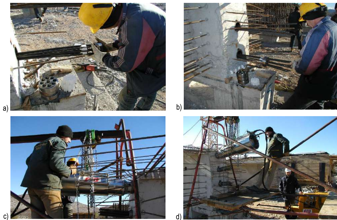
Slika 7.15 – Izvođenje naknadnog prednapinjanja nosača nekog mosta - prednapinjanje
