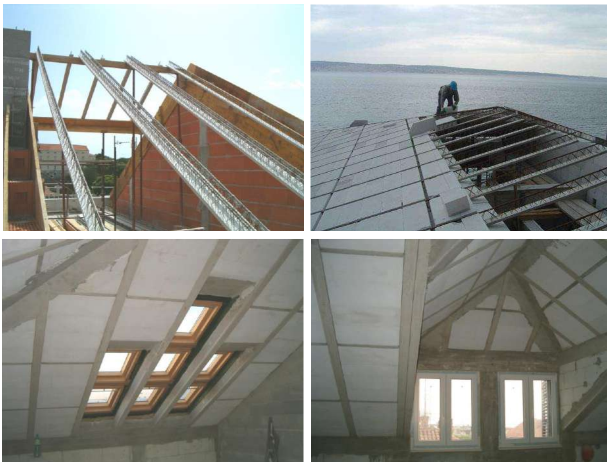
Slika 6.49 – Neki detalji izvedbe Bijelog stropa
