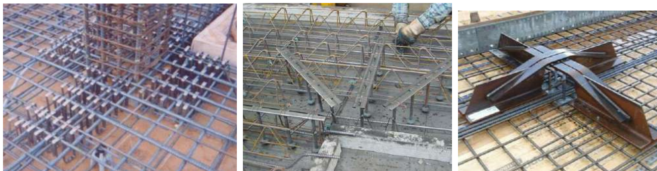
Slika 6.18 – Armatura protiv proboja ploče
