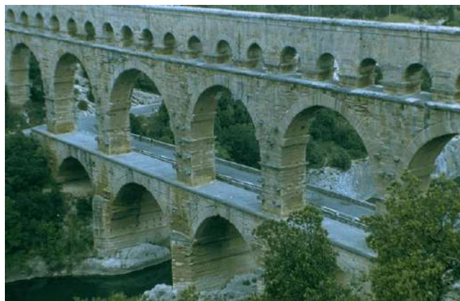
Slika 1.2 – Akvadukt Pont du Gard
