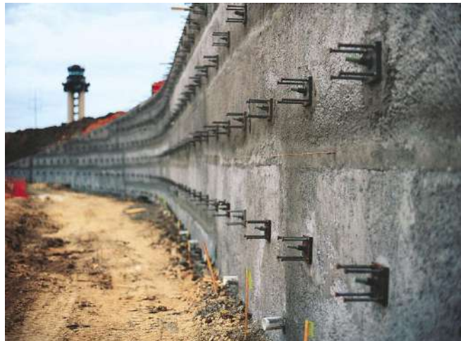
Slika 7.46 – Potporni zid u Dallasu, Fort Worth Aerodrom učvršćen Dywidag Soil Nails sidrima
