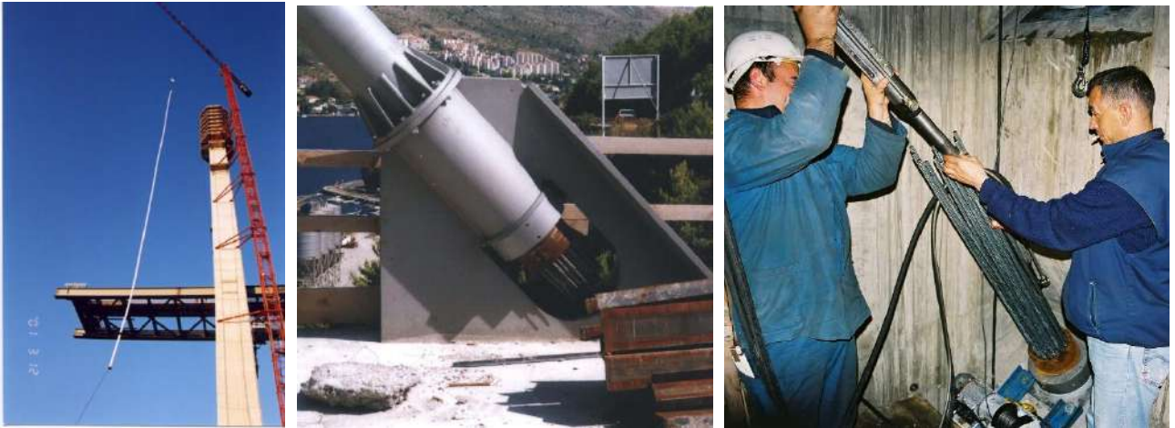
Slika 7.42 – Most Dubrovnik (Most dr. Franje Tuđmana) – izvedba vješaljki: podizanje vješaljke, učvršćenje i prednapinjanje
