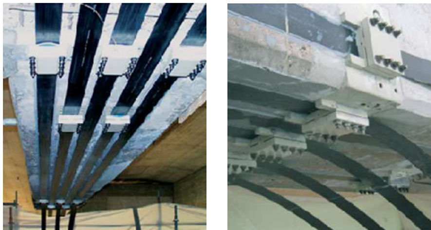
Slika 7.47 – Obnova mosta prednapetim karbonskim trakama
