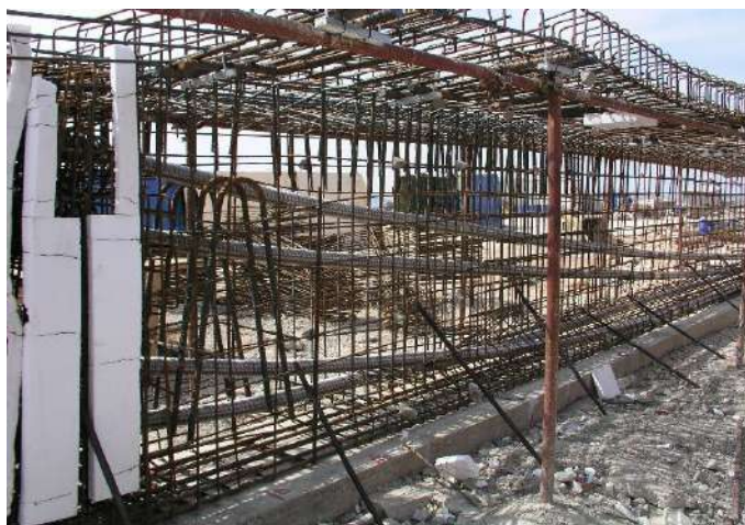
Slika 7.8 –Unutarnje prednapinjanje
