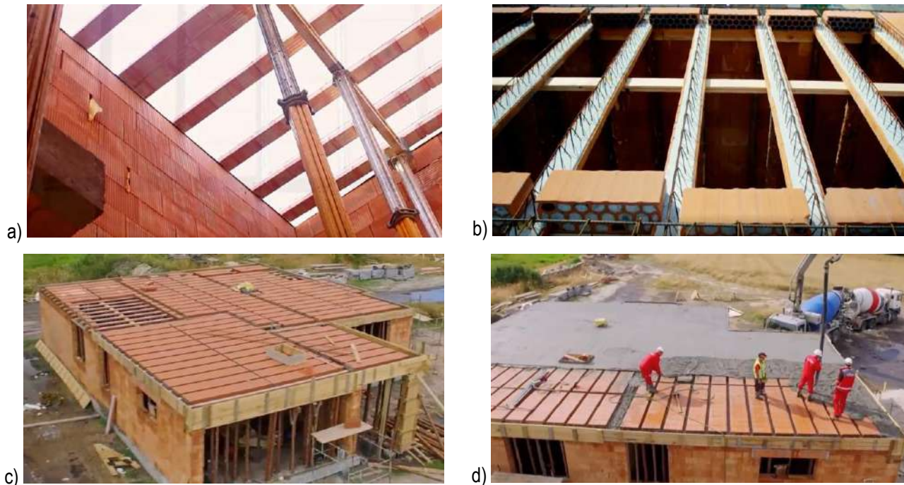
Slika 6.47 – Sustav Fert – Faze izvedbe Fert stropa
