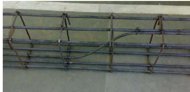
Slika 3.20 – Kosa armatura u armiranobetonskoj gredi
