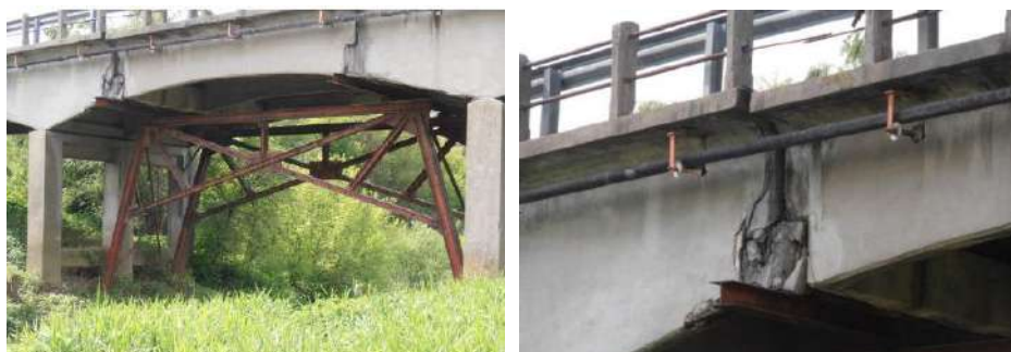
Slika 6.77 – Most preko kanala Bientina, Italija; Slom Gerberova zgloba [15]
