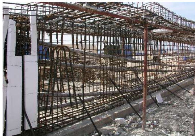
Slika 7.8 –Unutarnje prednapinjanje
