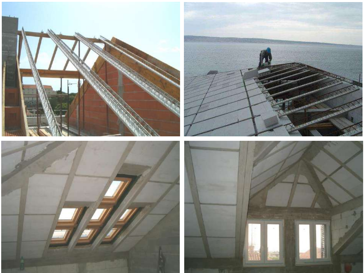
Slika 6.49 – Neki detalji izvedbe Bijelog stropa
