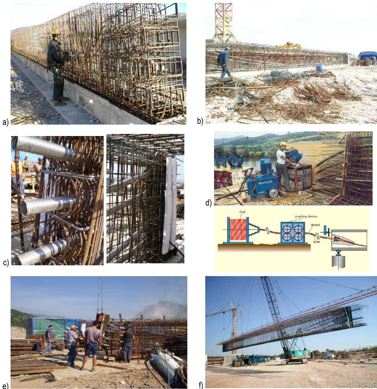
Slika 7.13 – Izvođenje naknadnog prednapinjanja nosača nekog mosta –postavljanje armaturnog koša i cijevi za provlačenje užadi
