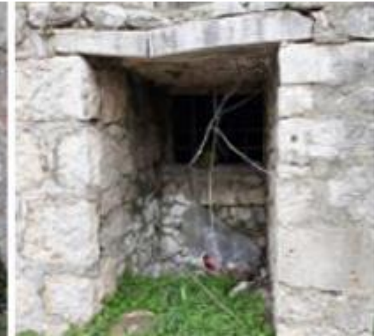
43) Detalj otvora ispod podesta
