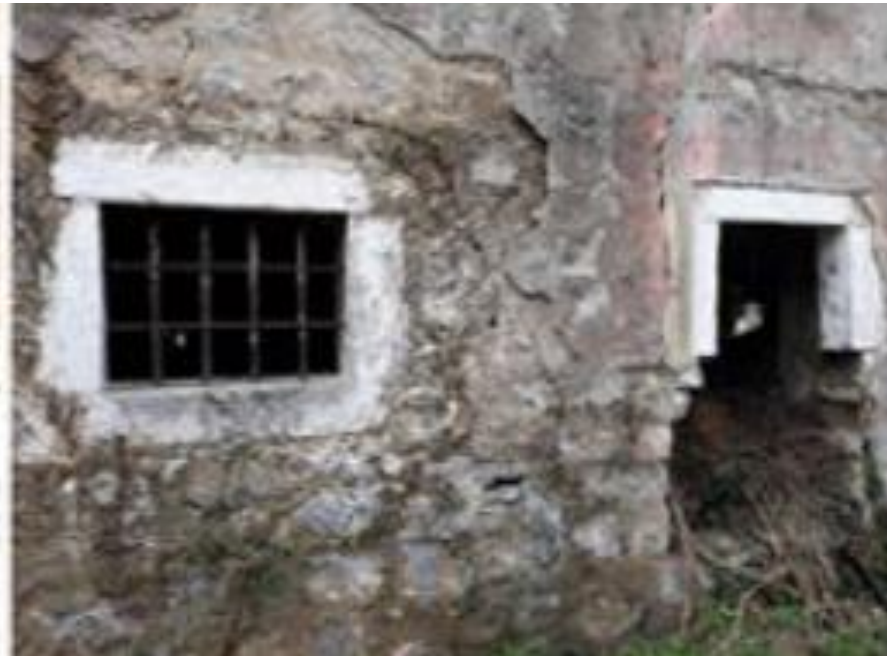
42) Detalj sjeverne fasade
