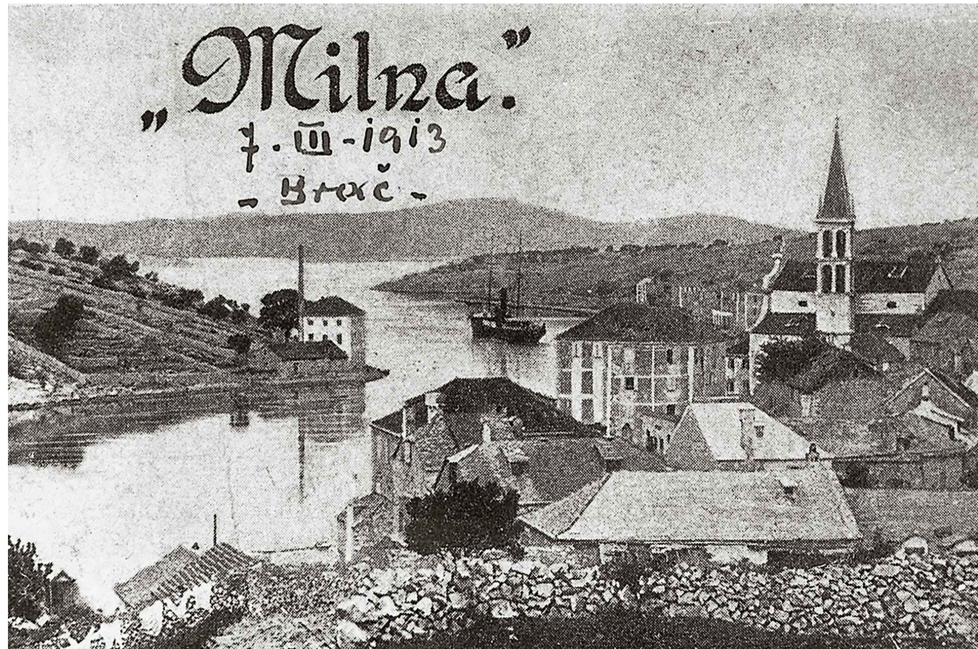
42. Pogled prema zapadu: vide se parni mlin (Bijela kuća) s dimnjakom i parobrod dok se prema desno proteže mjesto. 1913.
