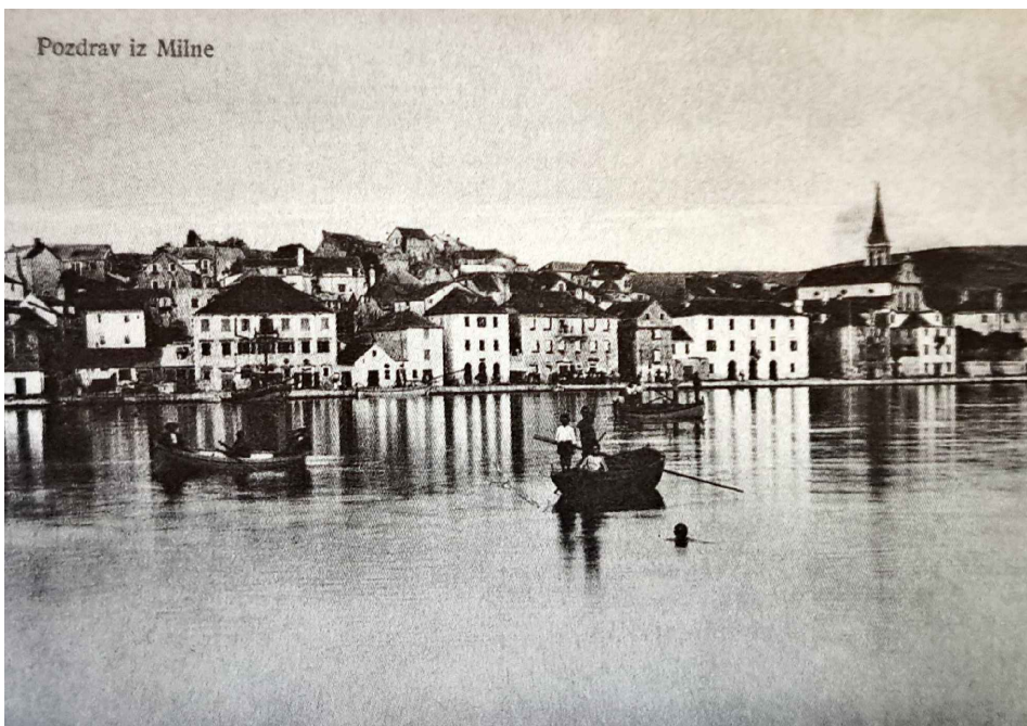
44. Milnarska svakodnevnica i impozantne kuće na riv početkom 20.st.
