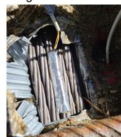
**Slika 6.** Mjerni senzori na betonu i prednapetom čeliku
