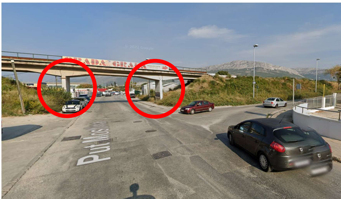
Slika 41. Problem željezničkog nadvožnjaka [2]
