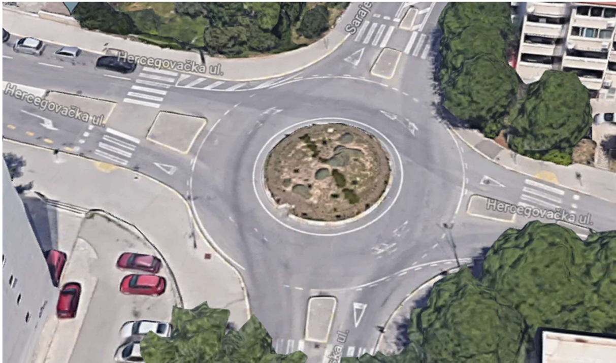
Slika 22. Postojeći kružni tok u Hercegovačkoj ulici [2]
