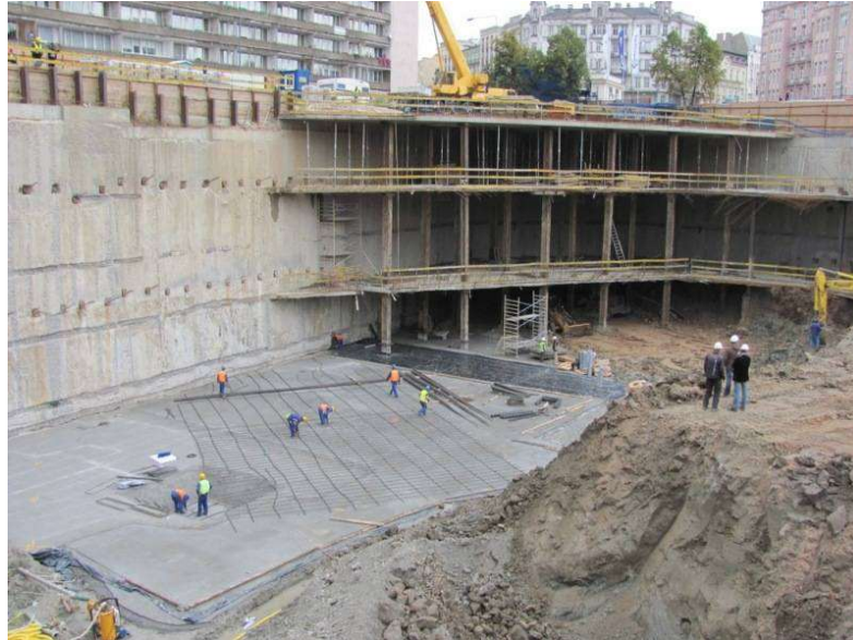
Slika 3. Primjer armirano – betonske dijafragme
