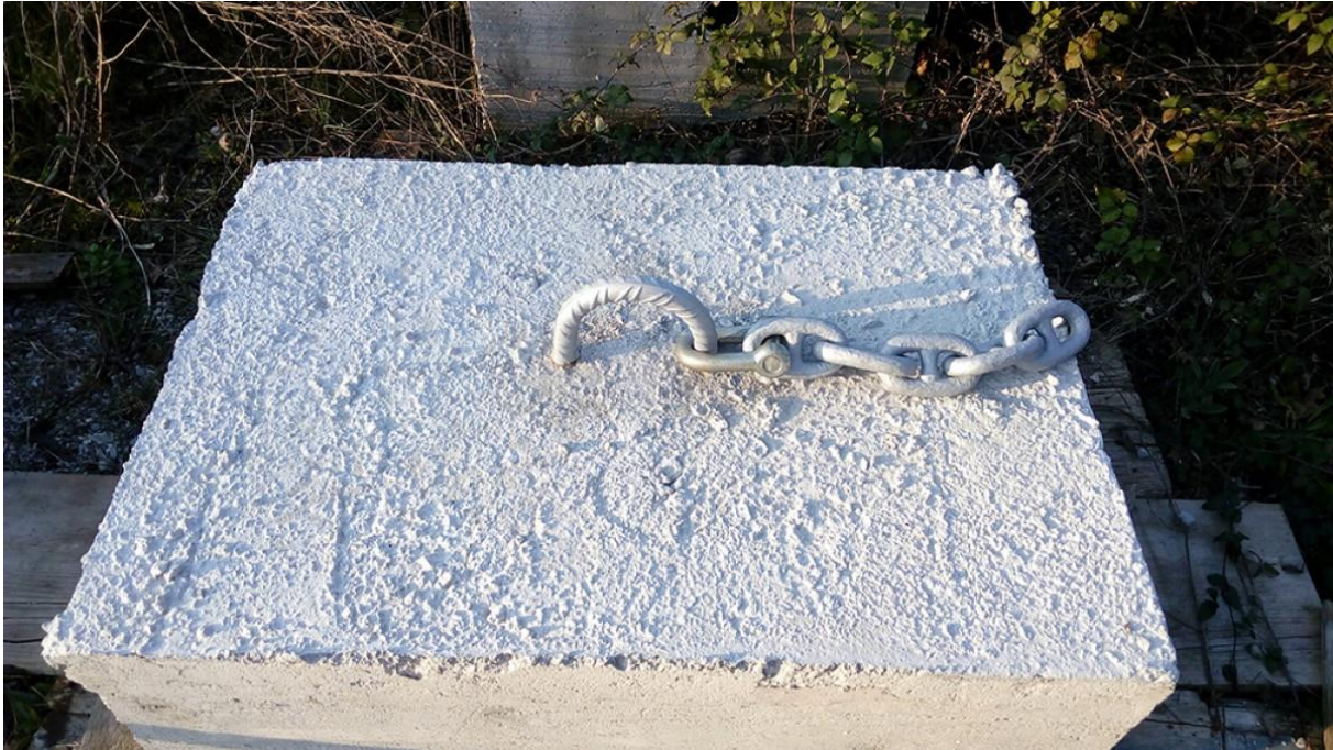
Slika 123 Primjer sidrenog betonskog bloka
