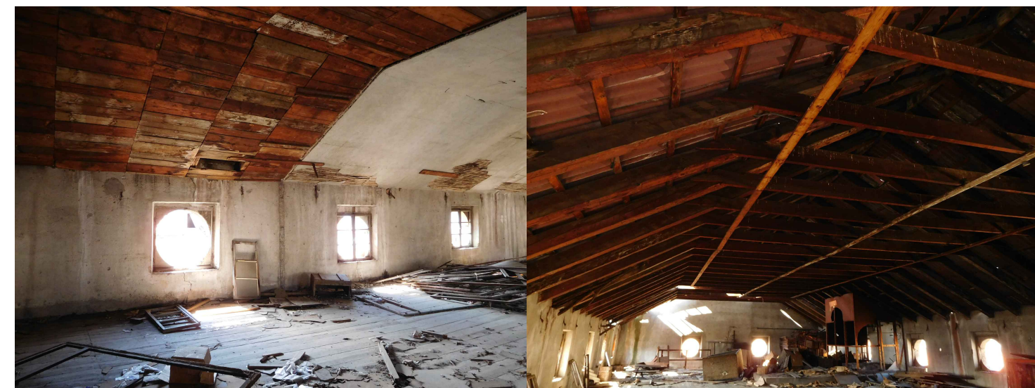
Slika 41.; 42. Podkrovlje zgrade A - trenutno stanje
