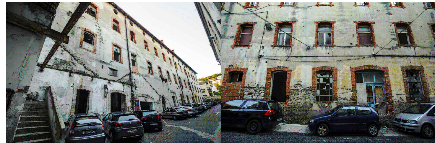
Slika 43.; 44. Dvorište kompleksa - trenutno stanje
