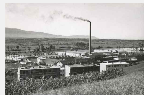
Revitalizacija tvornice u Zaboku - industrijska baština [ https://pogledaj.to/wp-content/uploads/2015/09/44-Zabok1.jpg ]
