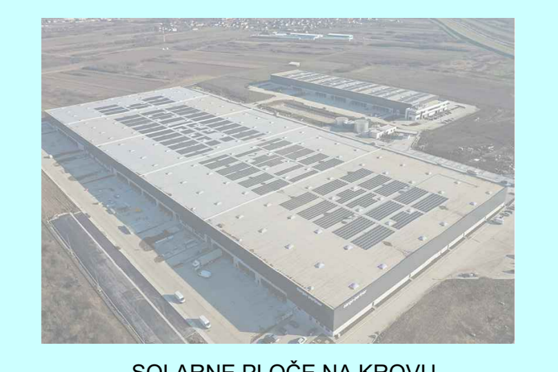
SOLARNE PLOČE NA KROVU
