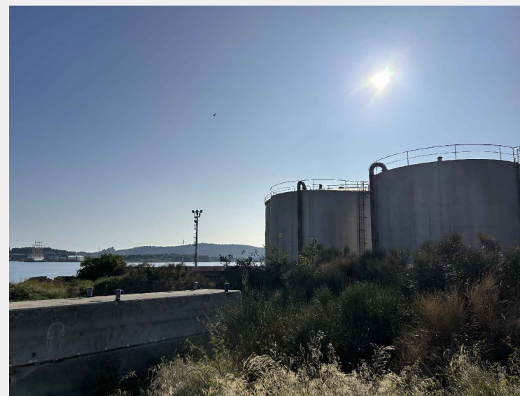
jugoistočni rub obuhvata uz more-spremište mazuta
