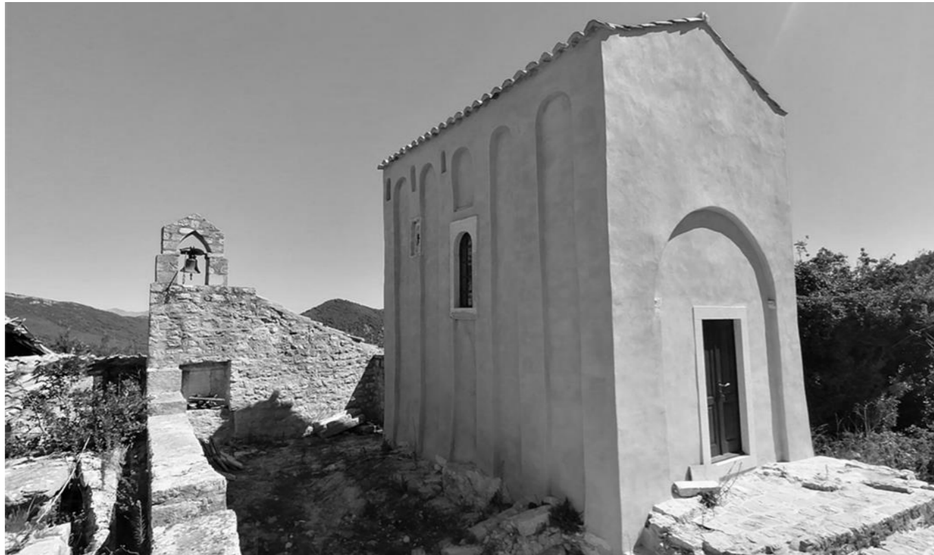
Crkva sv. Mihajla kod Stona – Pročelje; Foto: Nemanja Todorović Štiplija (6)
