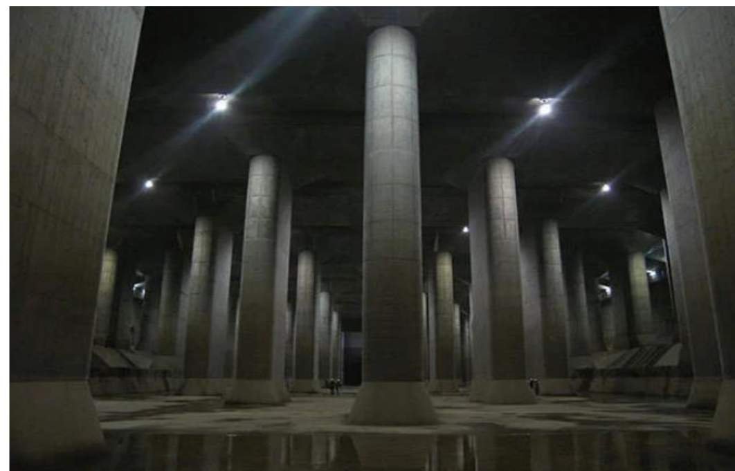
slika 8 – Prepumpna kontrolna stanica u sustavu G-Cans
