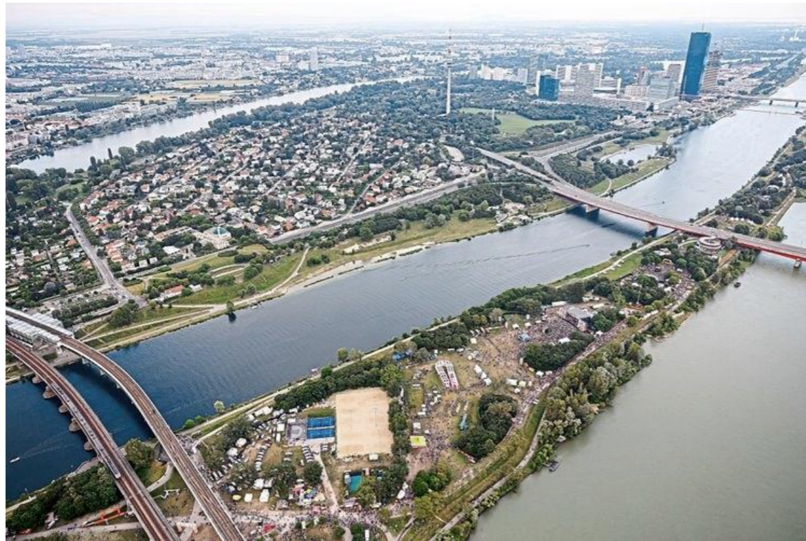
slika 7 – Zračni prikaz kanala Novi Dunav sa središnjim otokom
