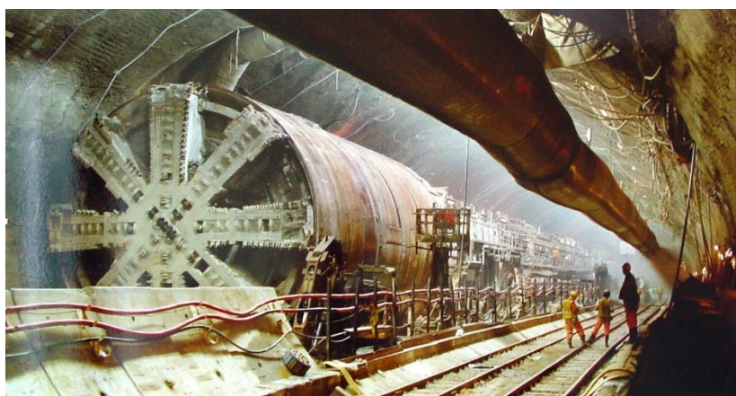
Slika 2. Primjer probijanja tunela [3]
