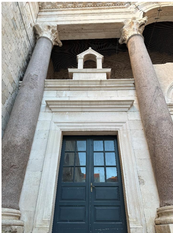
Slika 3. Stupovi od crvenog granita
