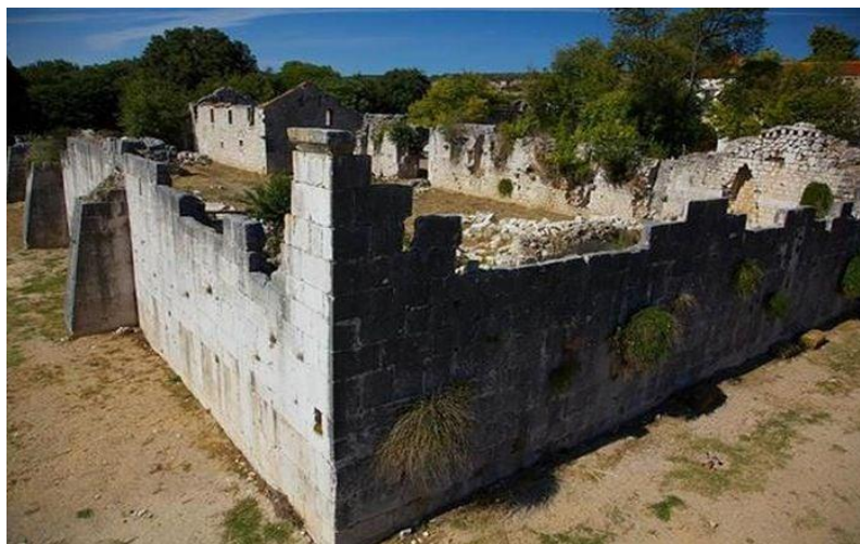
Slika 33: Han Jusufa Maškovića prije rekonstrukcije [17]
