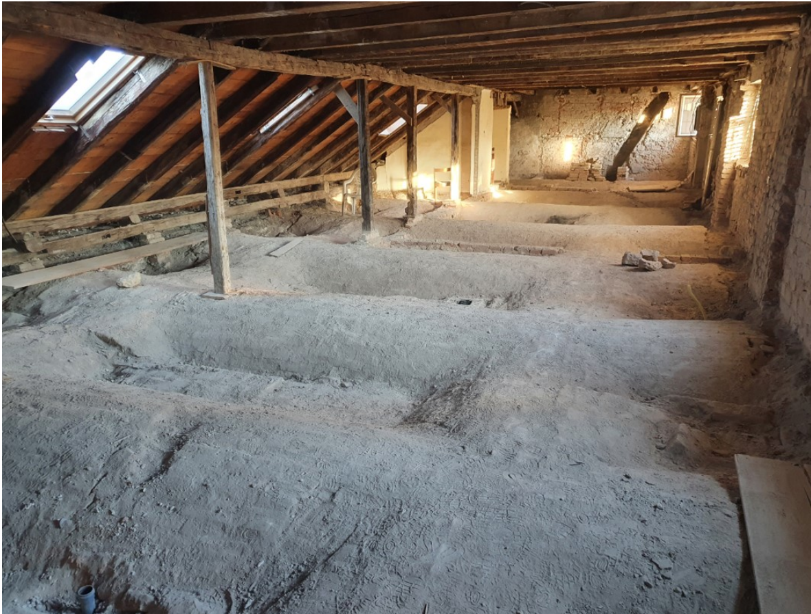
Fotografija 1.11 – Zidani svodovi u Samostanu sv. Franje Asiškog, Kaptol
