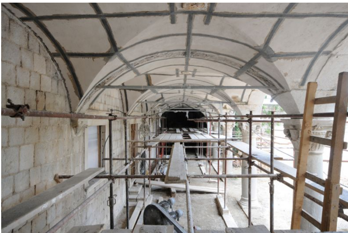
Fotografija 1.13 – Ojačanje svodova po intradosu
