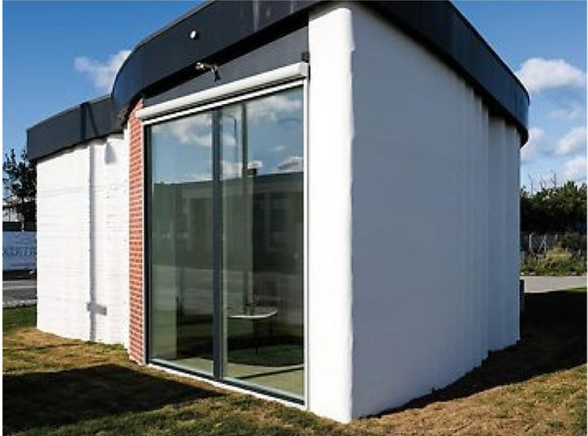
Slika 5: Kuća u Danskoj sa zakrivljenim 3D printanim zidovima (izvor: Milad Bazli, Hamed Ashrafi, Ali Rajabipour, Cat Kutay, 3D printing for remote housing: Benefits and challenges, Automation in Construction, 2023.)
