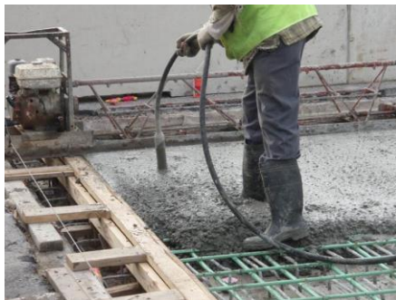
Slika 10. Vibrator za beton sa vibro iglom
