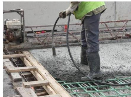
**Slika 10. Vibrator za beton sa vibro iglom**
