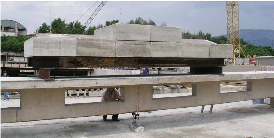
Slika 3.5. III faza opterećenja (8 betonskih blokova)
