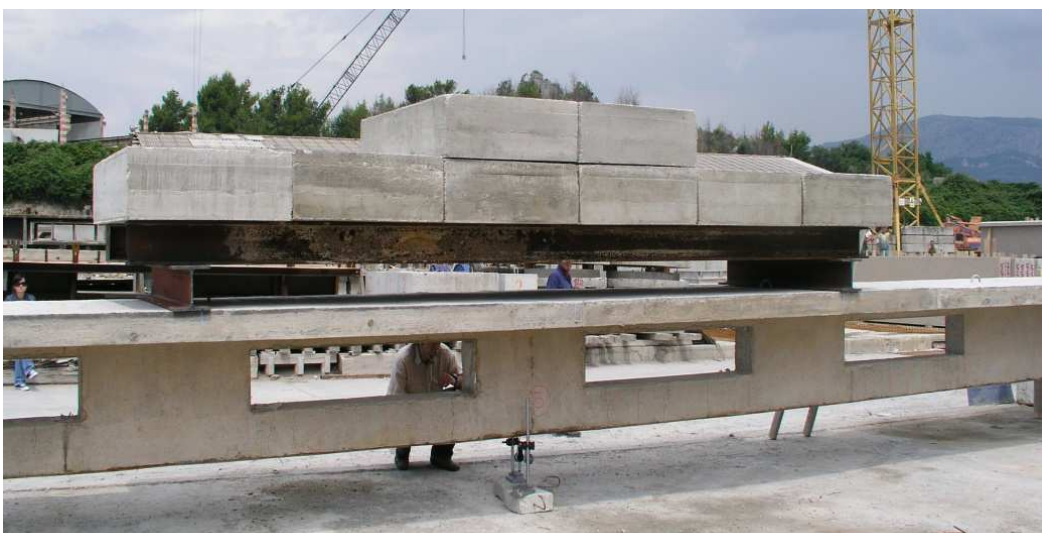
Slika 3.5. III faza opterećenja (8 betonskih blokova)
