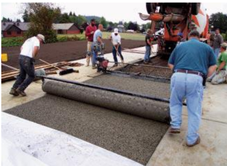
Slika 2.11 Zbijanje poroznog betona čeličnim valjkom [9]
