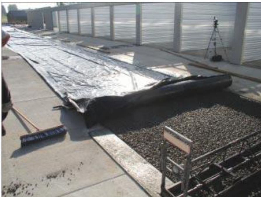
Slika 2.13 Prekrivanje poroznog betona plastičnom folijom [9]
