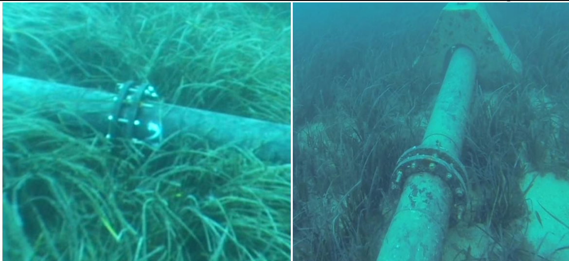
Slika 8. Druga prirubnica, 135 metara nakon početka novog dijela cjevovoda
