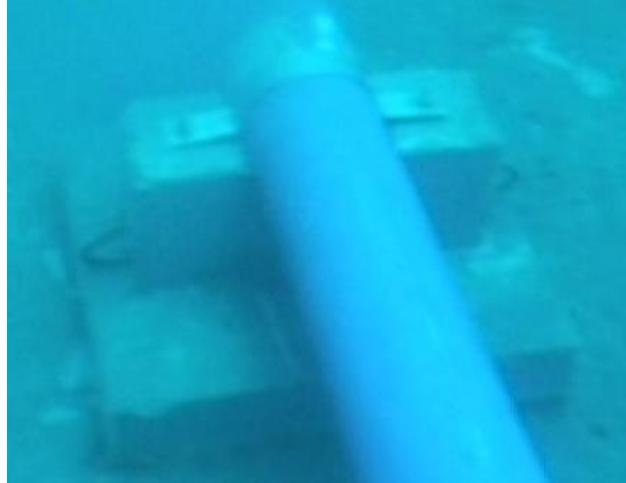
*Slika 3. Detalj betonskog podmetača difuzora*
