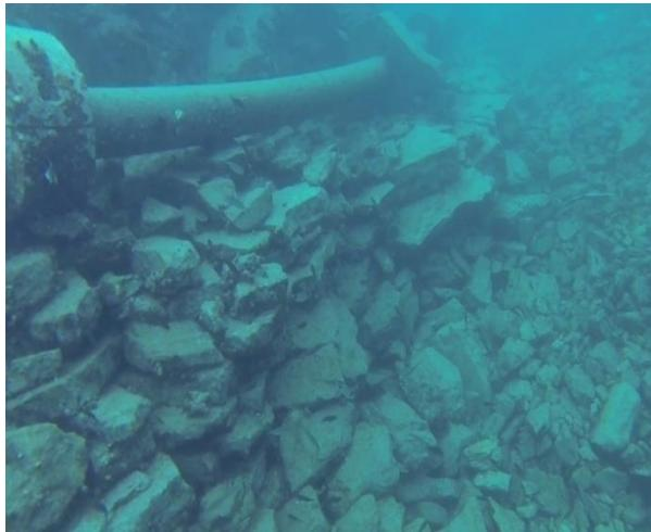
Slika 19. Improvizirani zid od pločastog kamena na ulazu cjevovoda u rov
