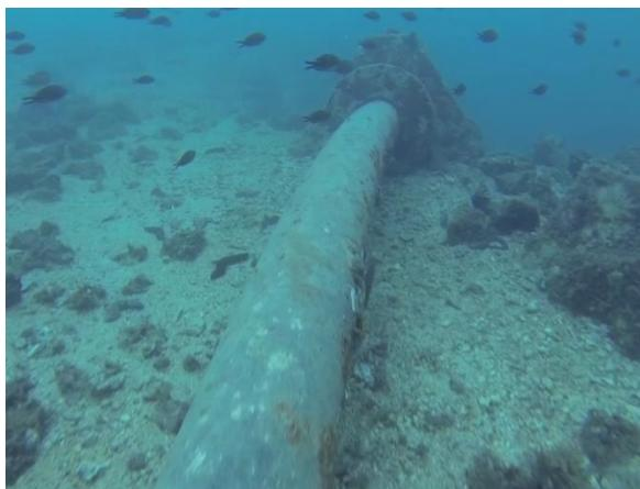
Slika 17. Vertikalni lom cjevovoda na ulazu u rov
