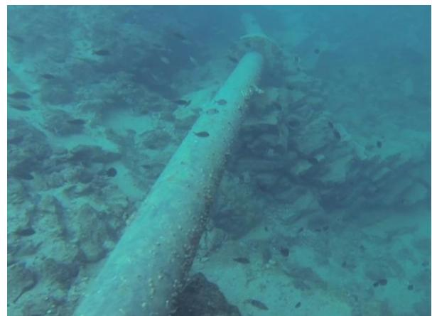
Slika 18. Vertikalni i horizontalni lom cjevovoda
