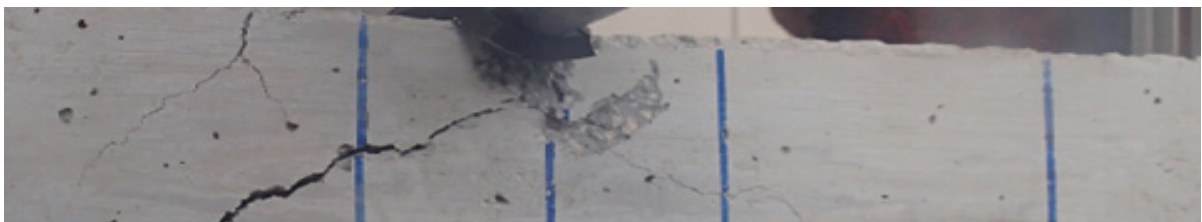
Fotografija 4.17. Grede G2 tijekom nanošenja sile, prikaz lokalnog oštećenja
