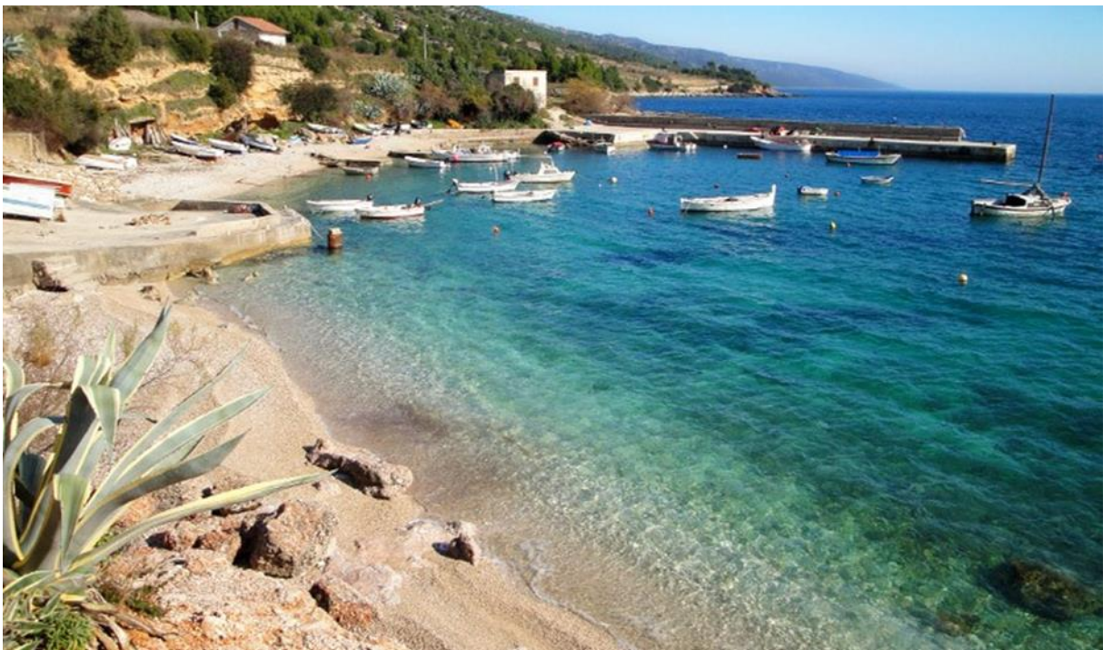
Slika 2.3. Pogled na postojeći lukobran
