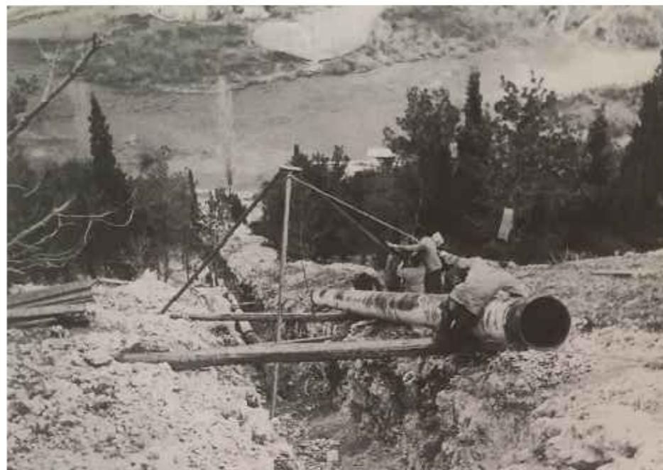
Radovi na vodovodu Krka - Ražine, 1951. godine
