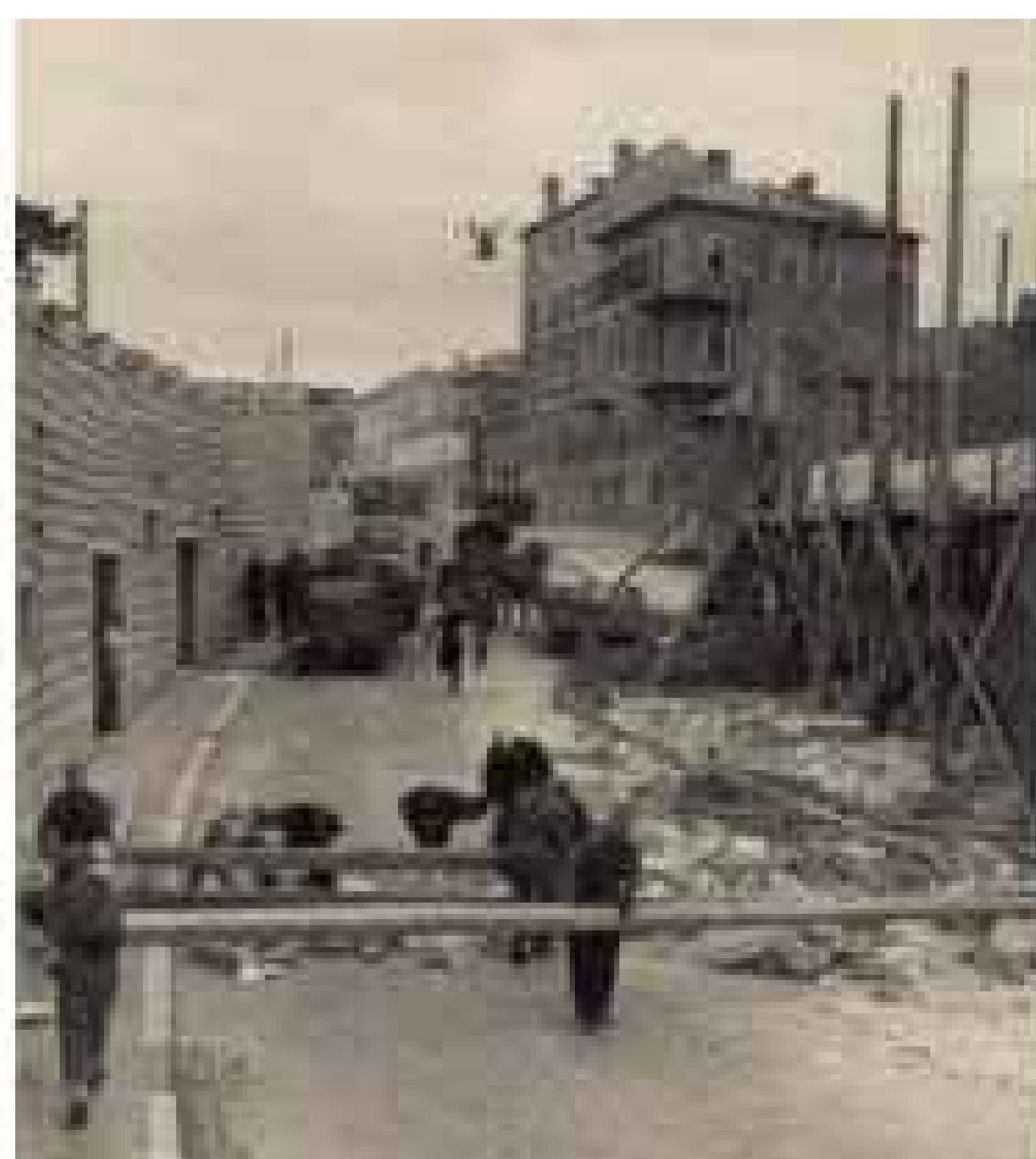
Izgradnja ceste, 1857. god
