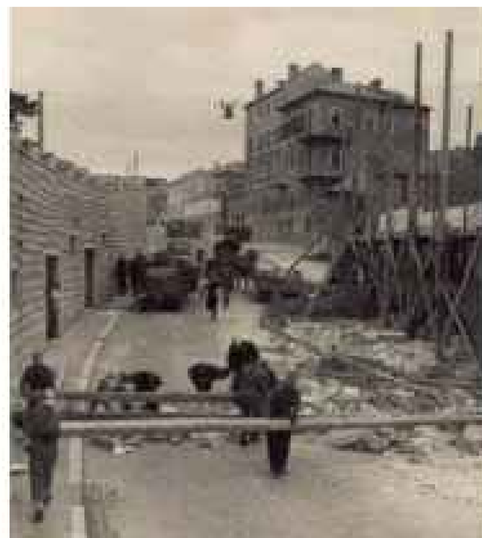
Izgradnja ceste, 1857. god
