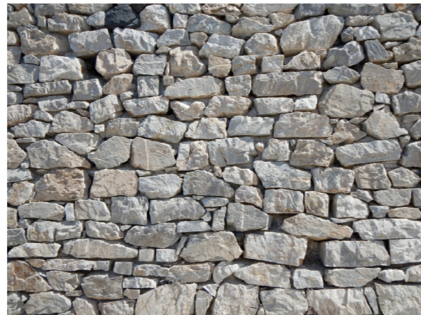
BENKOVAČKI KAMEN ( tradicionalno zidanje )
