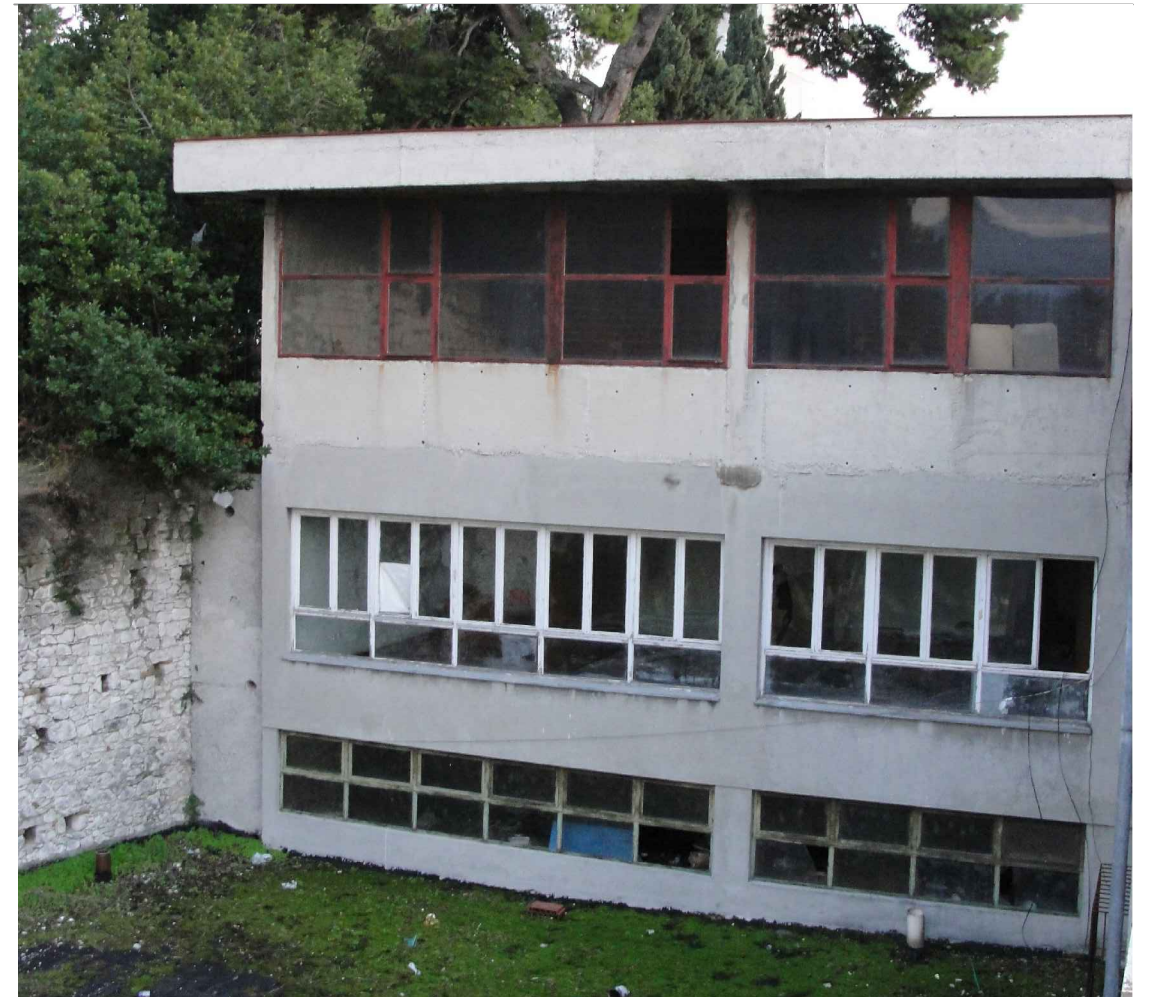
Slika 21. Zgrada aneksa - današnje stanje ( P. Galošić)
