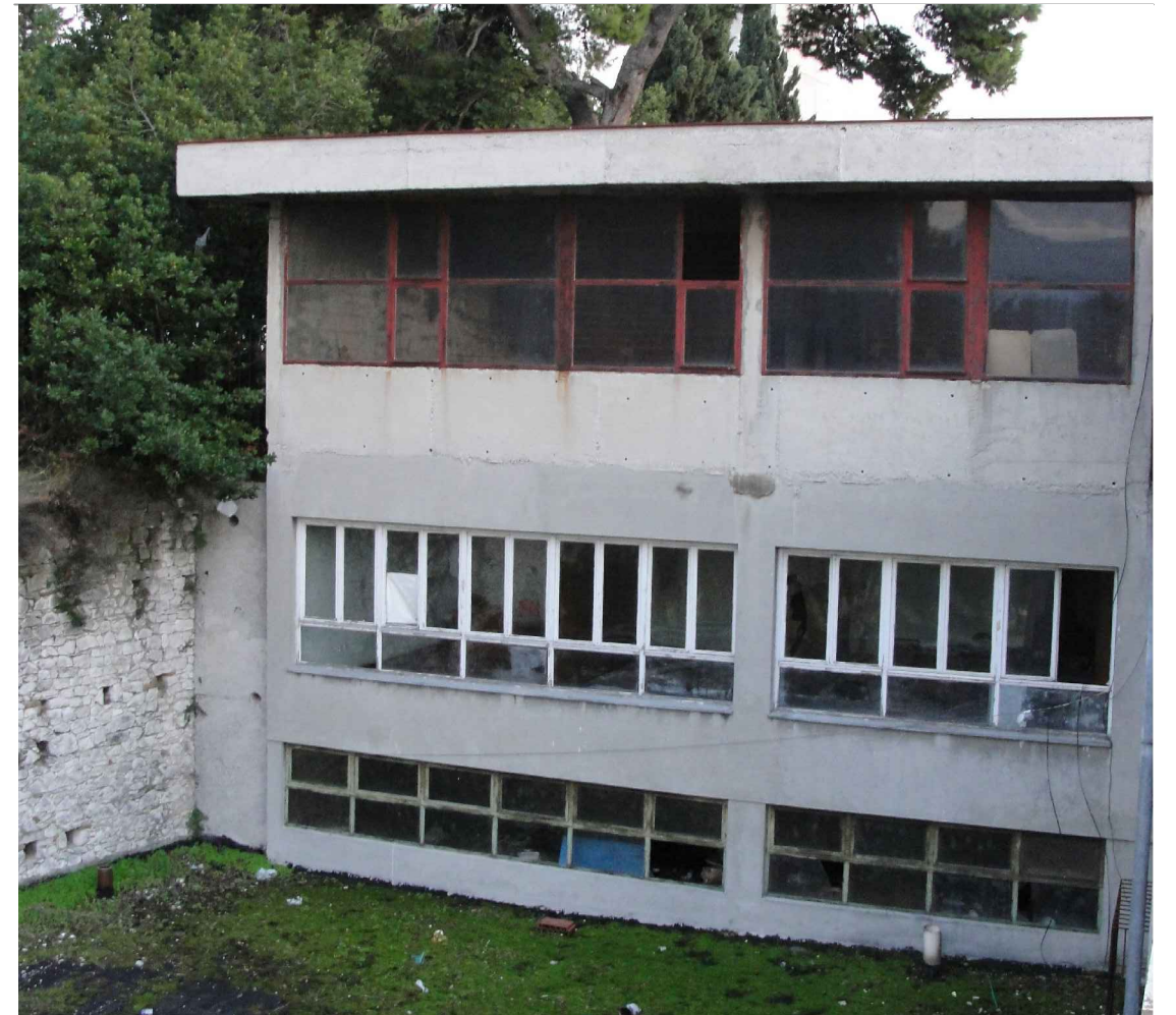
Slika 21. Zgrada aneksa - današnje stanje ( P. Galošić)
