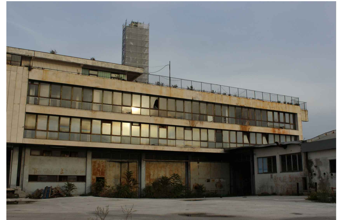
Slika 19. Zgrada skladišta - današnje stanje ( A. Burić)
