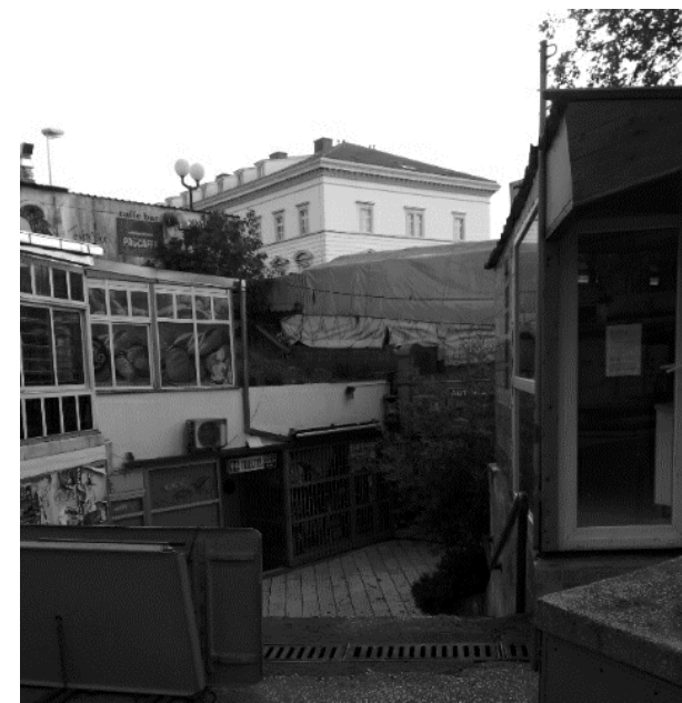
Prilaz u pothodnik - nastao kao privremeno rješenje
