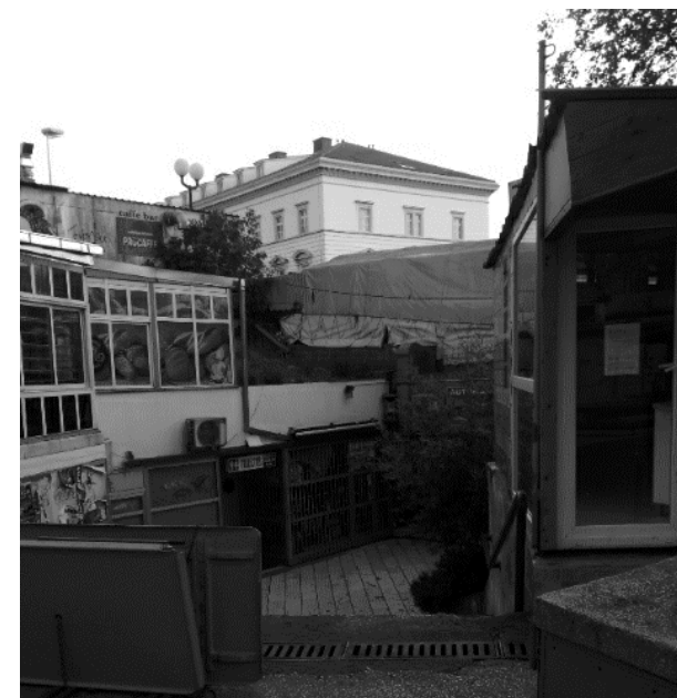
Prilaz u pothodnik - nastao kao privremeno rješenje
