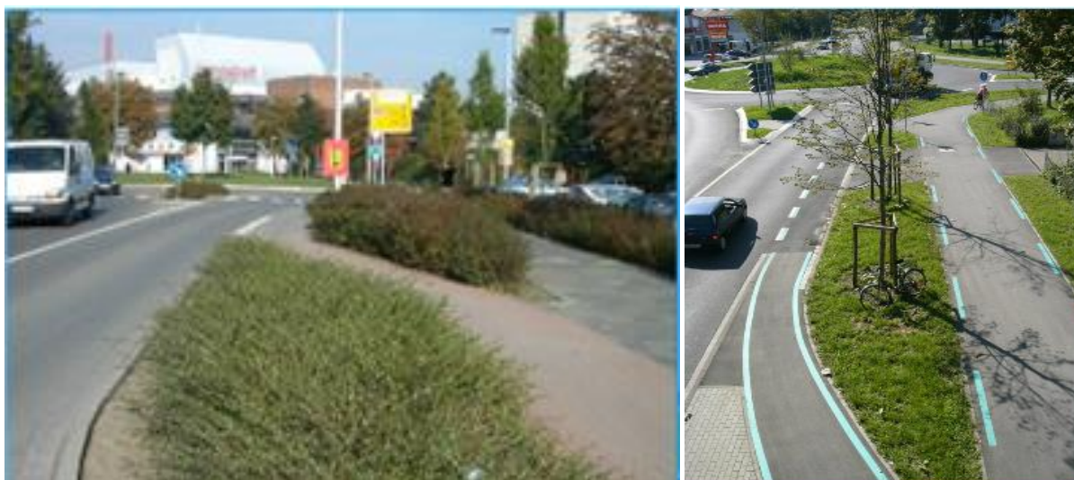
Slika 26. Usmjeravanje biciklističke staze na cestu
