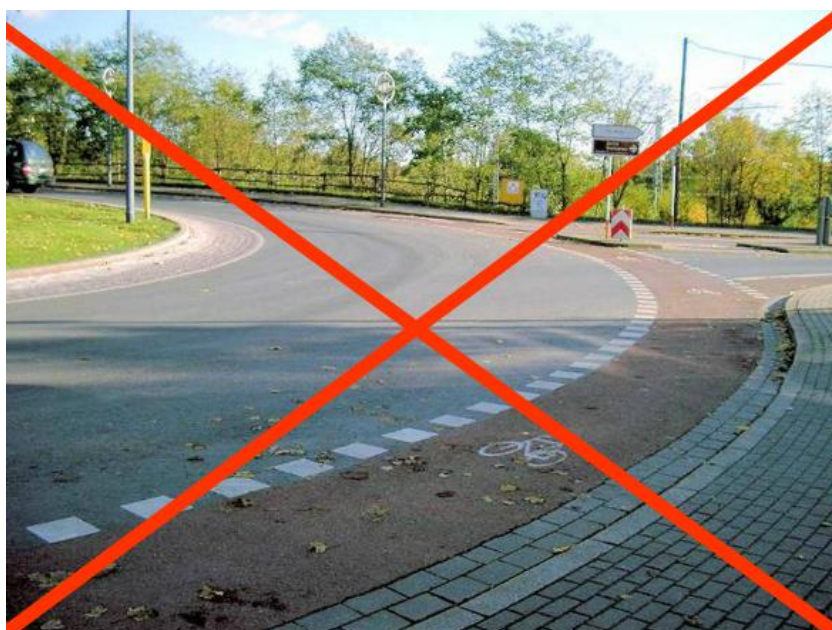
Slika 24. Pogrešno postavljanje biciklističke staze
