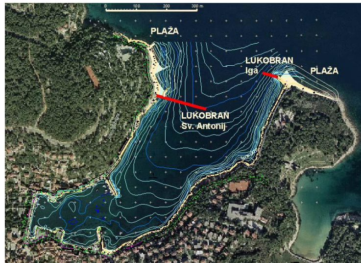
Slika 17. Plaže s vanjskih strana lukobrana
