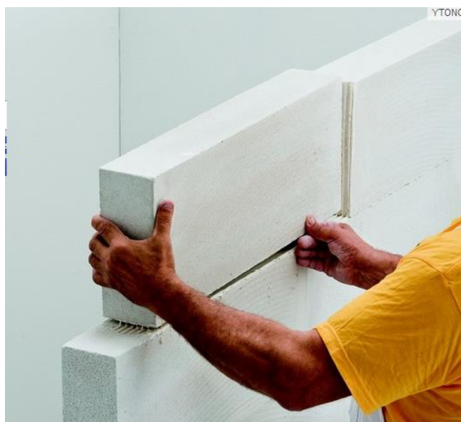
Slika 3.1. Zidanje pregradnih zidova od siporeksa [15]
