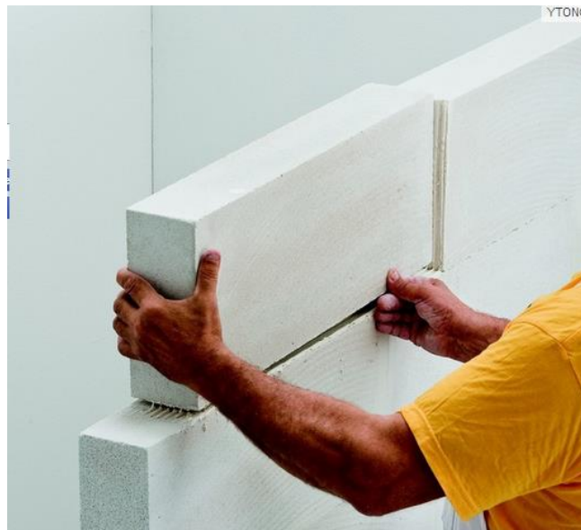
Slika 3.1. Zidanje pregradnih zidova od siporeksa [15]
