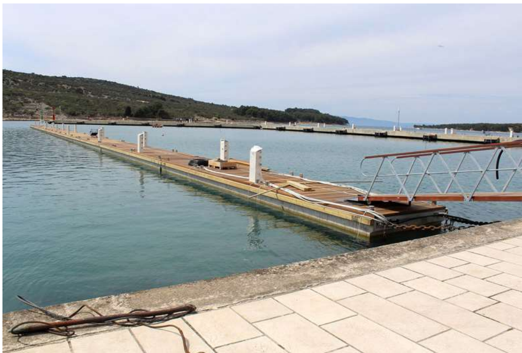
Slika 5.1 Primjer pontonske marine u Cresu koju je izvela tvrtka Marinetek NCP [27]
