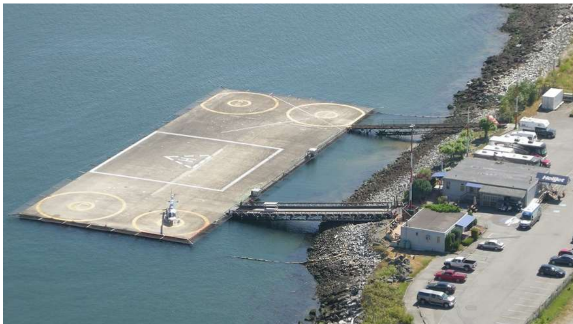
Slika 2.16 Helidrom u Vancouveru, Kanada [4]
