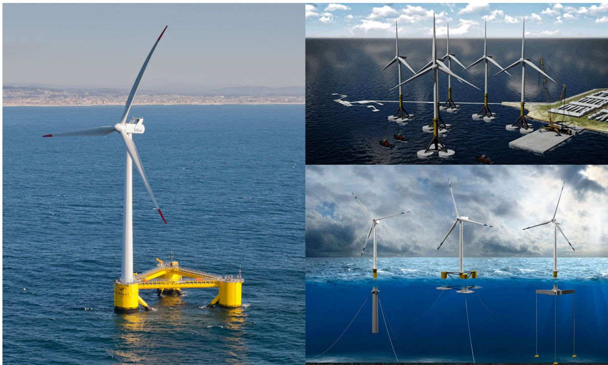
Slika 2.21 Primjer već izvedene polu-potopljene vjetroelektrane, te različitih 3d modela [8]
