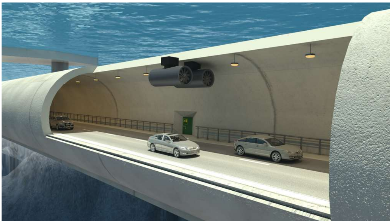
Slika 2.20 Primjer modela potopljenih plutajućih tunela [7]
