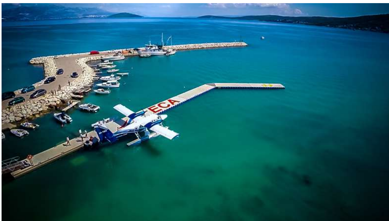
Slika 5.3 Hidroavionsko pristanište u Divuljama na Hvaru [27]
