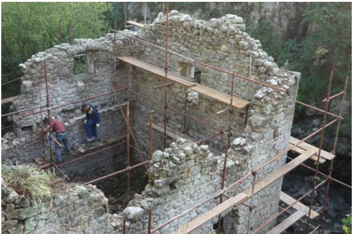
Slika 20. Obnova stare mlinice
