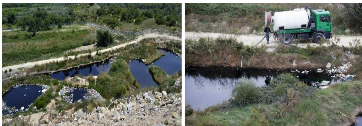
Slika 19. Retencijske lagune procjednih i oborinskih voda odlagališta Karepovac
