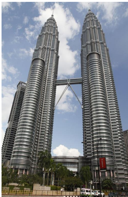
Slika 1.1.: Petronas Twin Towers izgrađen od samozbijajućeg betona 1998. godine [3]
