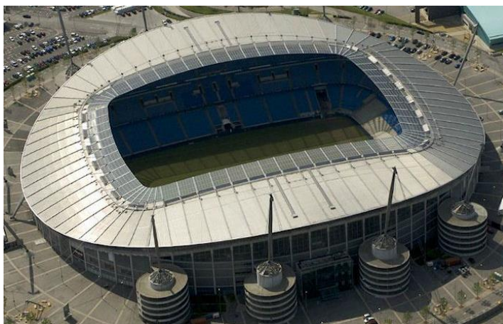
Slika 1.2.: Petronas Etihad, sportski stadion u Manchester, sidreni blokovi koji podupiru krov stadiona izgrađeni od samozbijajućeg betona, 2002. godine. [7]
