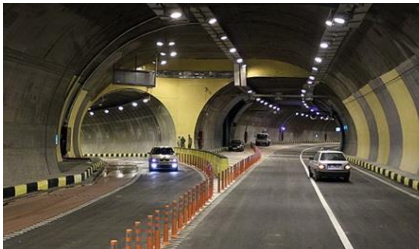
Slika 1.3.: Niayesh tunel, tunel u Teheranu (Iran), izrađen od samozbijajućeg betona 2012. godine [8]
