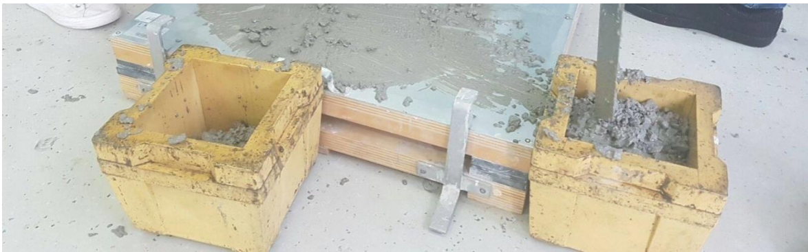
Slika 23. Kalupi za svježi beton
