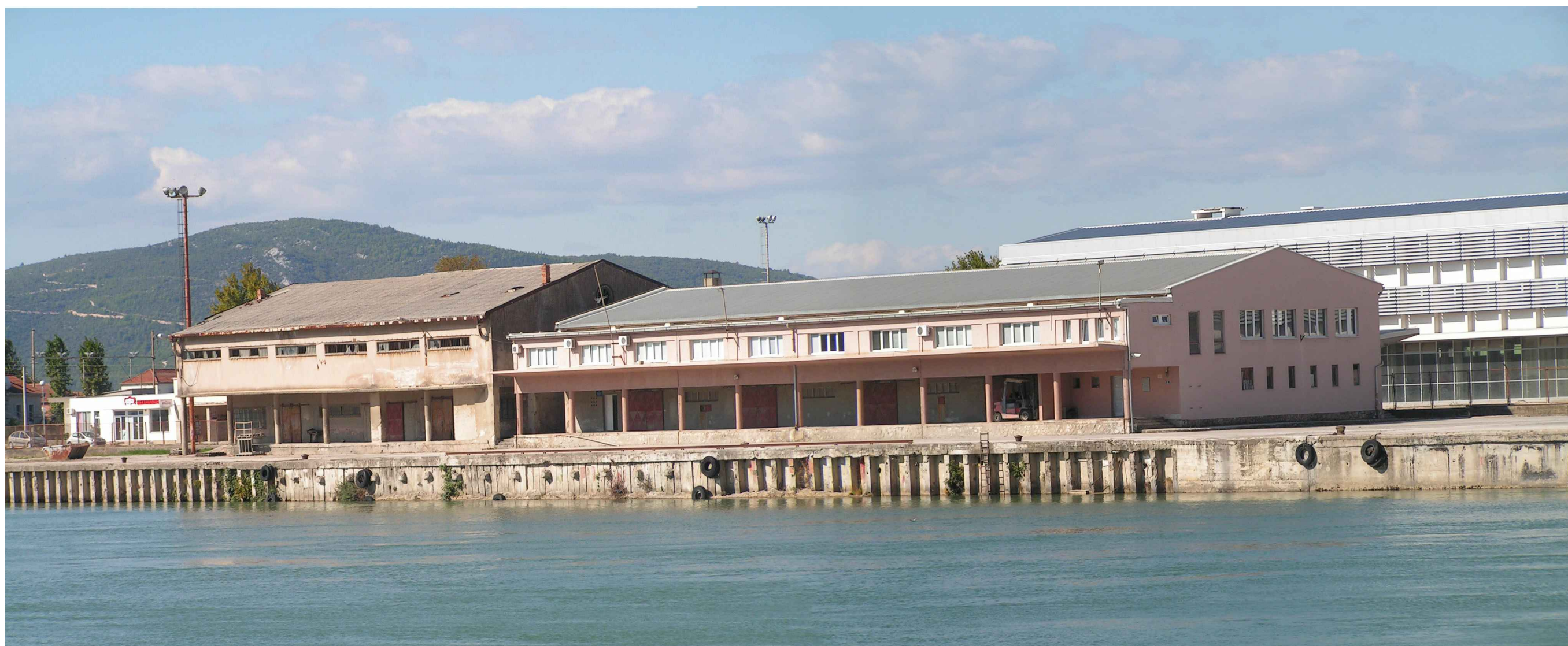
Pogled na dva preostala lučka skladišta - lijevo je u vrlo lošem stanju te je predviđeno rušenje
