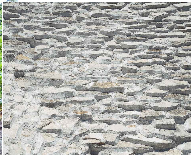
KAMENE PLOČE U VAPNENOM MORTU - korištene za pokrov starih poljičkih kuća
