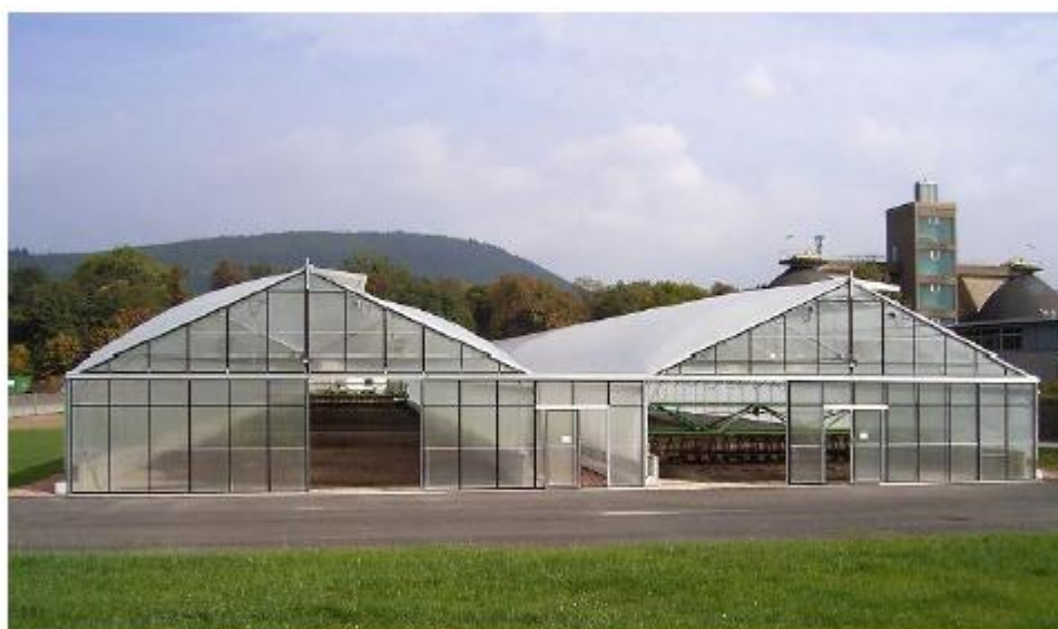
Slika 11.4.3. Postrojenje za solarno sušenje Main-Mud (Njemačka), 3.000 m 2 , 4.000t, mulj s 22 % ST/god
