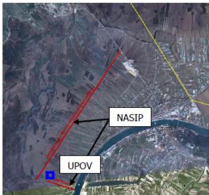
Slika 11.2. Prikaz nasipa u izgradnji
