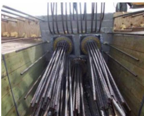
Slika 2.15 Sidro kabela za prednapinjanje [3]
