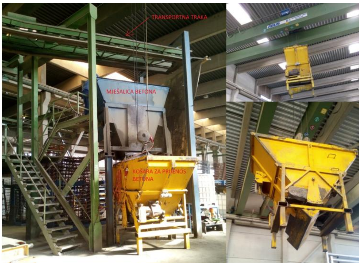
Slika 4.4 Priprema betonske mješavine te transport
