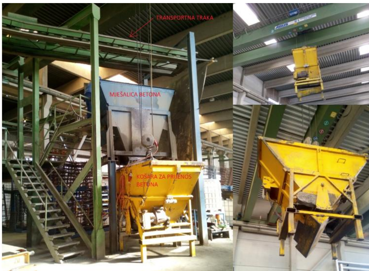
Slika 4.4 Priprema betonske mješavine te transport
