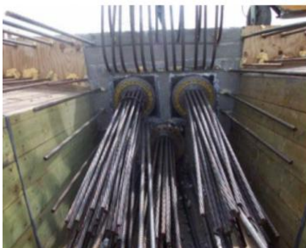
Slika 2.15 Sidro kabela za prednapinjanje [3]
