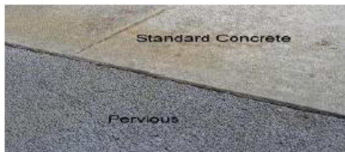
Slika 3.1 Usporedba poroznog i običnog betona [17]
