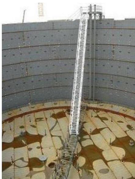
Slika 8. Plutajući krov
