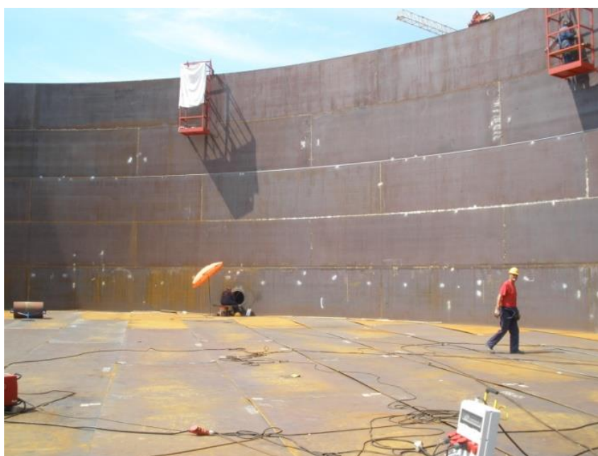
Slika 9. Plašt spremnika u izgradnji
