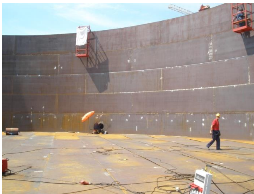
Slika 9. Plašt spremnika u izgradnji
