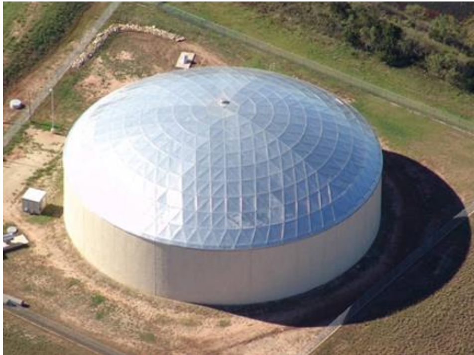
Slika 3. Nadzemni spremnik sa aluminijskom kupolom
