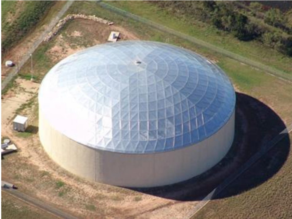
Slika 3. Nadzemni spremnik sa aluminijskom kupolom
