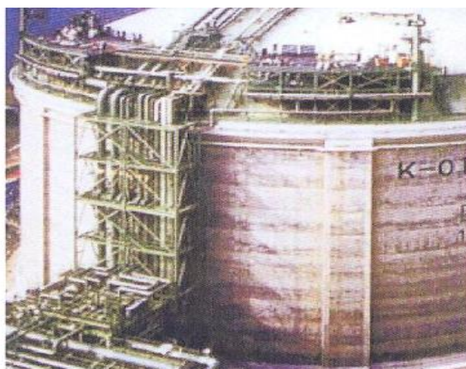
Slika 1.7.: Rezervoar LNG-a u Japanu [14]
