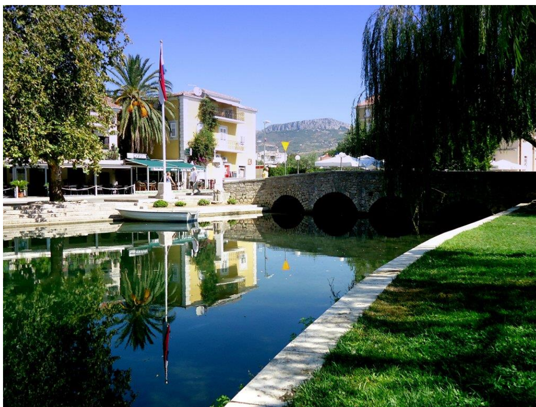
Slika 2. Most na rijeci Jadro u centru grada Solina
