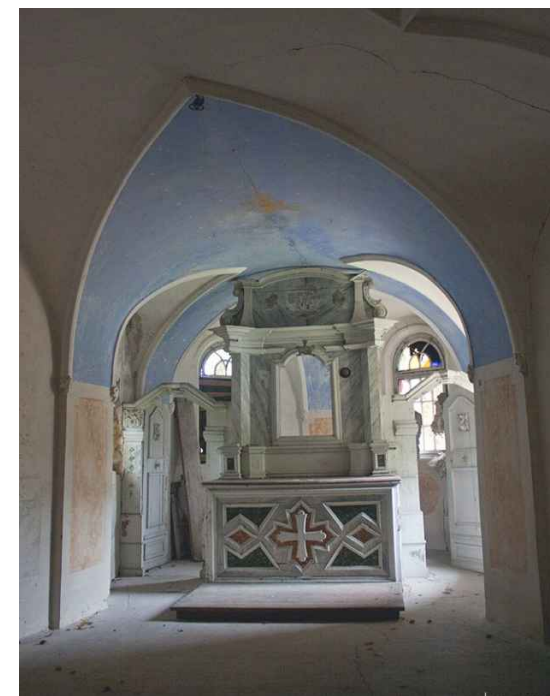
kapela prije restauracije
