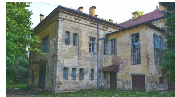
dvorac Bračak - prije obnove
