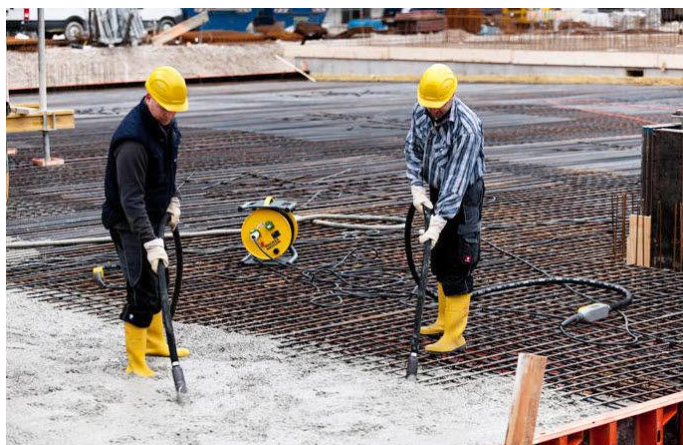
Slika 5.3. Korištenje vibro igle pri zbijanju betona [14]
